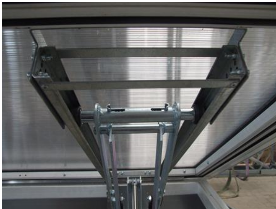
Rys. 25 Połączenie układu otwierającego prod. ACTULUX ze skrzydłem klapy oddymiającej mcr PROLIGHT.
