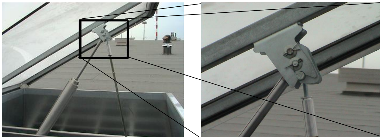
Rys. 24 Połączenie siłowników pneumatycznych lub elektrycznych prod. GRASL z konsolą hakową.
